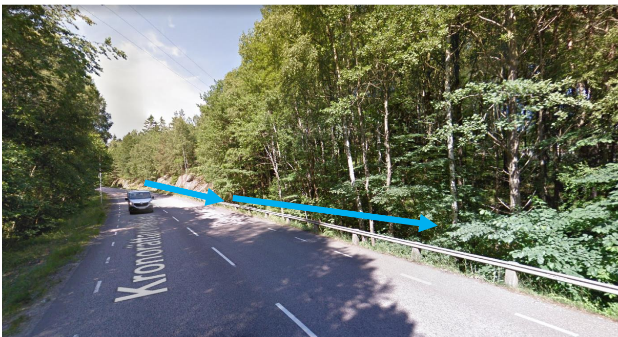
Figur 12: Avvattning redovisas via flödespilar. Bilden är taget från Kronorättarens väg mot norr. Diket går djupare ner i naturmarken till höger. Bildkälla: Google maps (bildinsamling Juni 2018).
